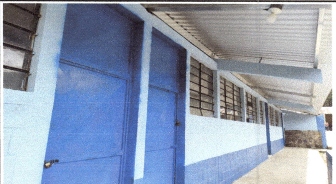
Foto 4: Mantenimiento a puertas realizado en módulo 2
