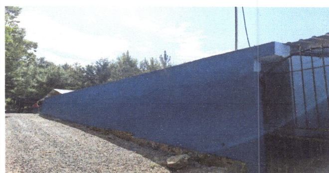
Foto 10: Muro rehabilitado, levantado de hiladas de block e implementación de canal de concreto
