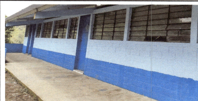
Foto 6: pintura sustituida en módulo 2
