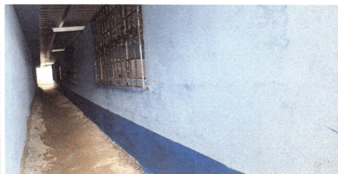
Foto 9: paredes rehabilitadas con aplicación de cernido y pintura.
