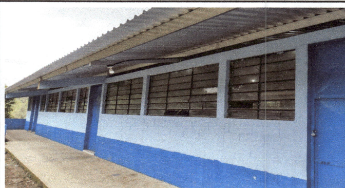
Foto 2: Estructura de techo y laminas sustituidas
