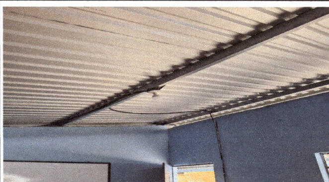
Foto 3: Laminass y estructura de techo sustituidas en aulas.
