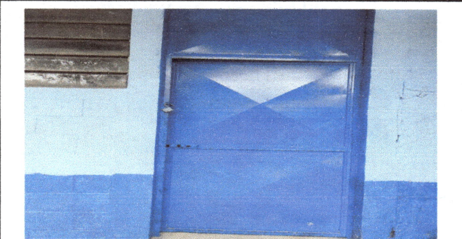
Foto 5: puerta de aula con pintura nueva.
