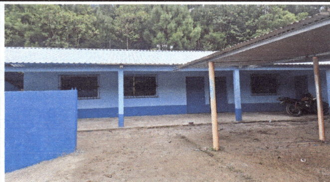
Foto 1: Estructura de techo y laminas sustituidas, cernido y pintura aplicados en paredes exteriores e interiores de módulo 1
